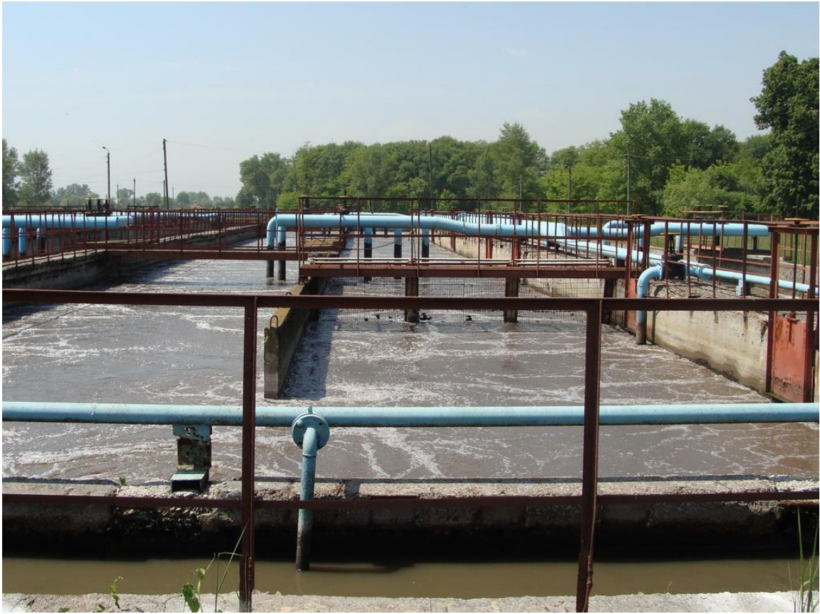
Очисні споруди КП «Чернігівводоканал» Чернігівської міської ради
